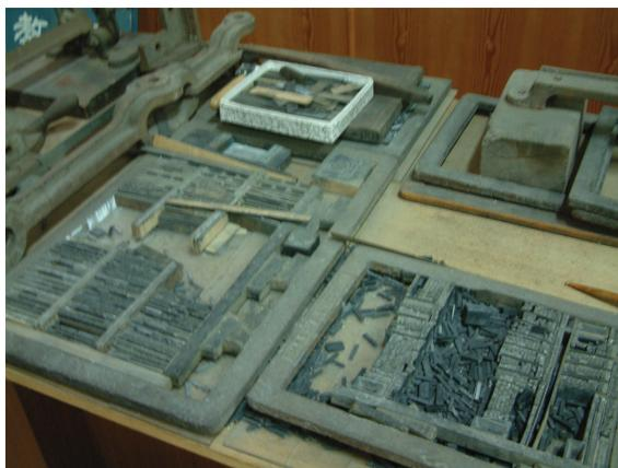
圖1：馬雅各所購置台灣第一部印刷機及字盤。
